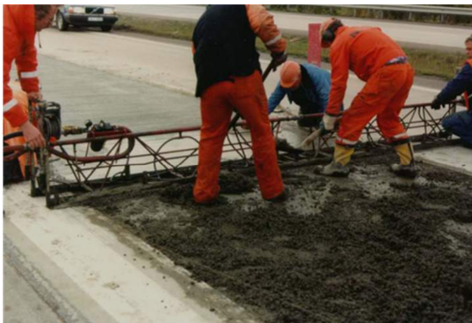
Figur 3 Tunn pågjutning efter fräsning (foto: Björn Kullander, Trafikverket)
