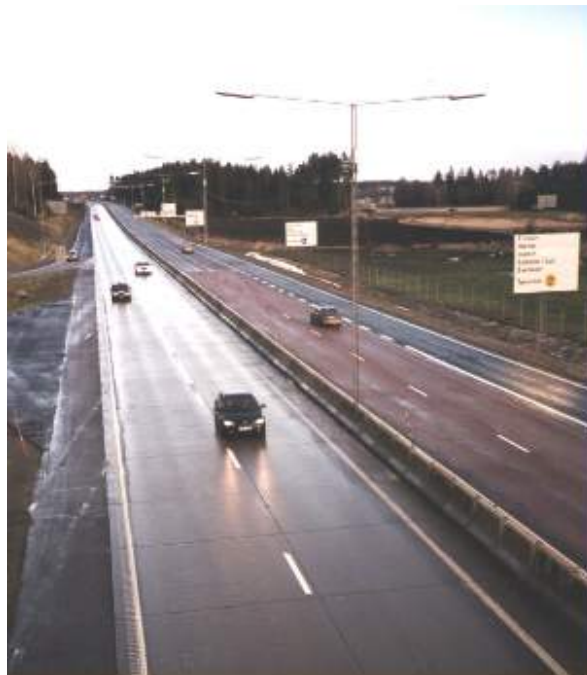
Figur 1 Betongväg vid Arlanda (foto: VTI)
