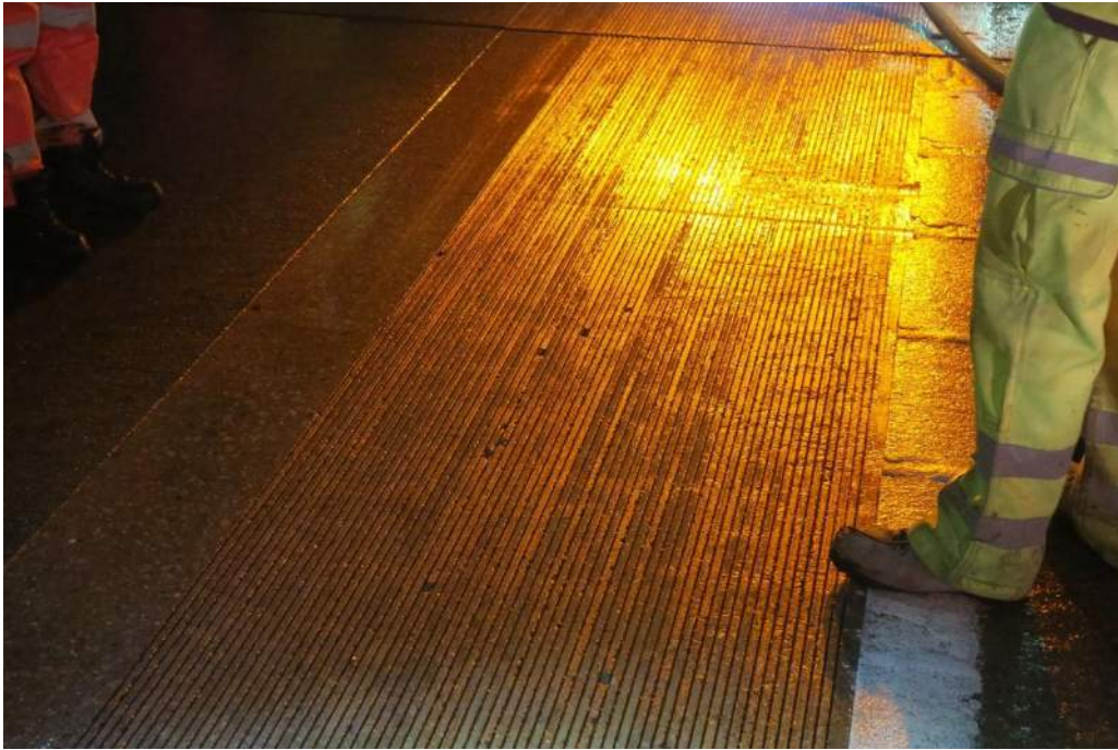
Figur 11 Resultat av slipning del av M1
