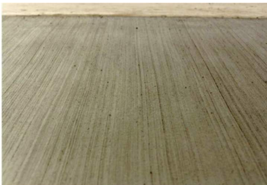
Figur 4 Slutlig yta (foto Björn Kullander, Trafikverket)
