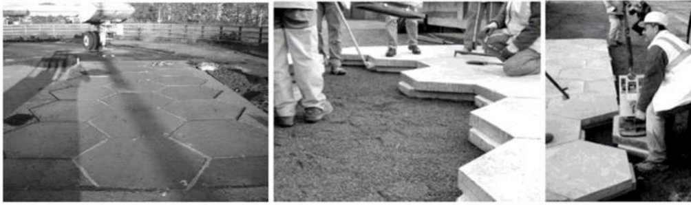
Figur 7 Installation av hexagonala betongplattor [6]
