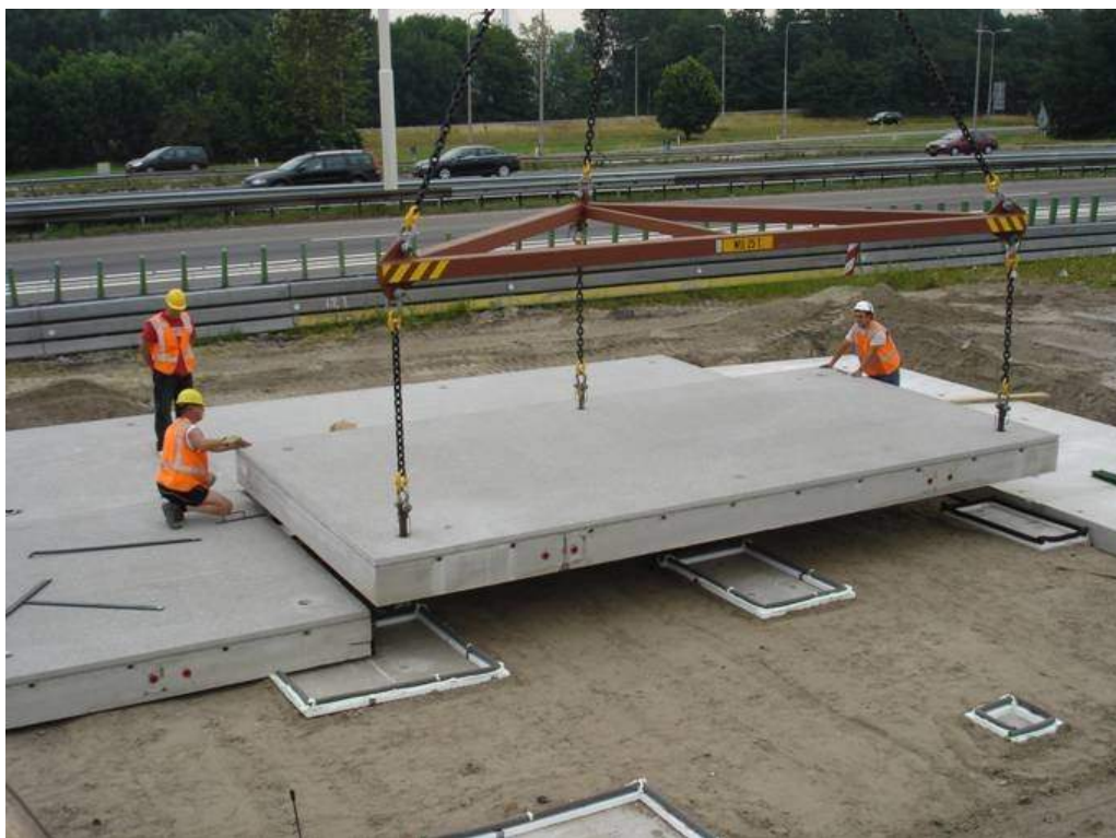
Figur 6 Utbyte av prefabricerade betongvägsplattor [5]
